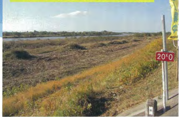
上佐々木地区(20k)施工中の状況
