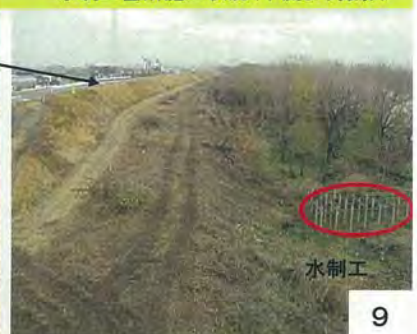
水制工箇所施工状況(下流より撮影)
