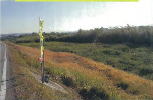
上佐々木地区(20k)施工前の状況
