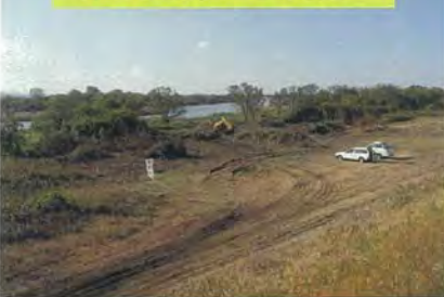
竹の伐採中の状況 1
