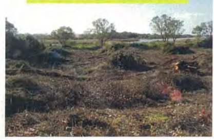
竹の伐採中の状況 3
