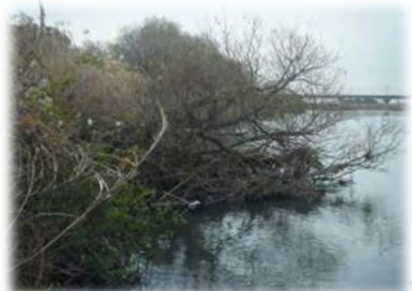
流木化の可能性があるヤナギの洗掘状況（矢作川の水辺）
