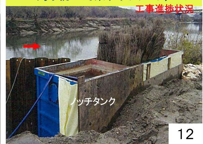
濁水防止対策(ノッチタンク)
