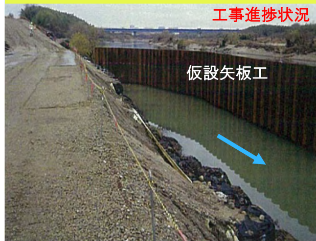
仮設締切矢板の施工状況
