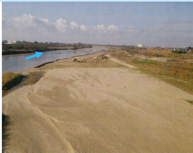
渡橋より撮影(河道掘削箇所 近景)
