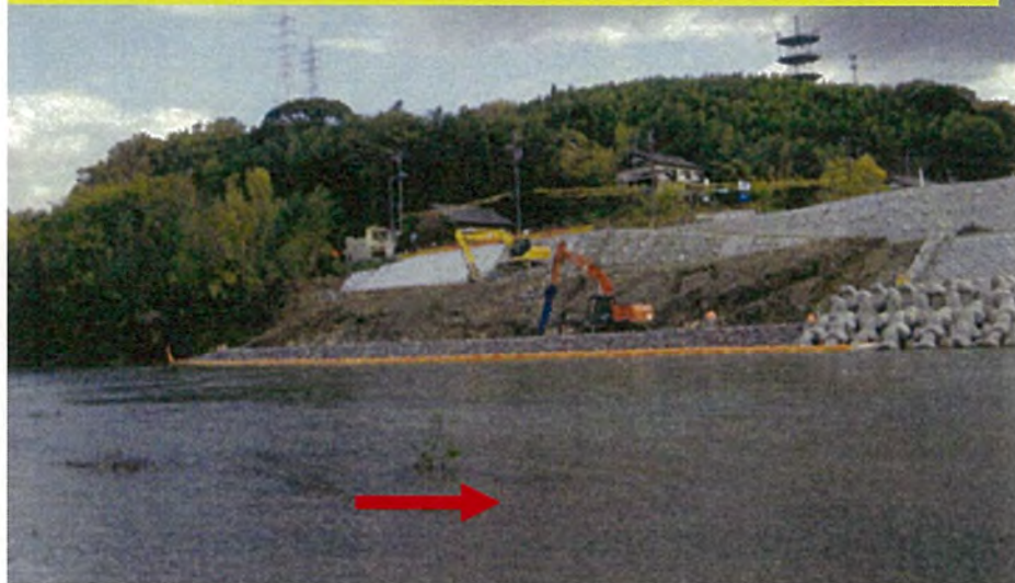
上流工区の施工状況(捨て石工)
