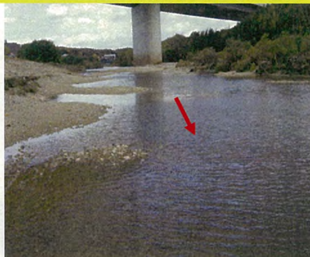
瀬替え箇所(中間部の状況)
