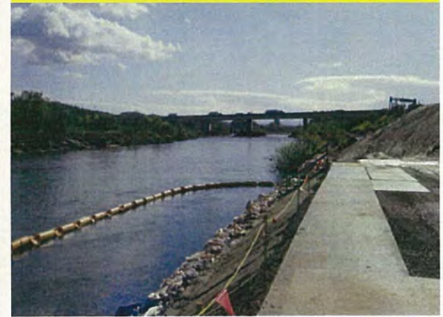
施工箇所を上流から撮影
