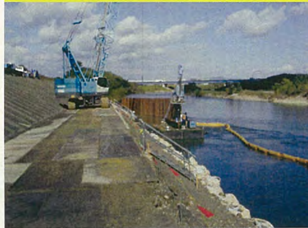
施工箇所を下流から撮影
