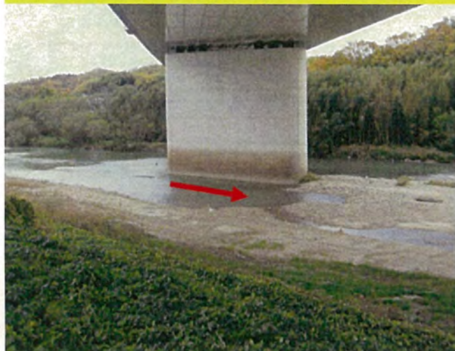
瀬替え箇所(上流部の状況)
