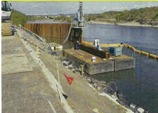
仮設工の締切り矢板施工中
