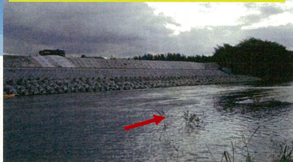
下流側工区の施工状況(工事は未実施)
