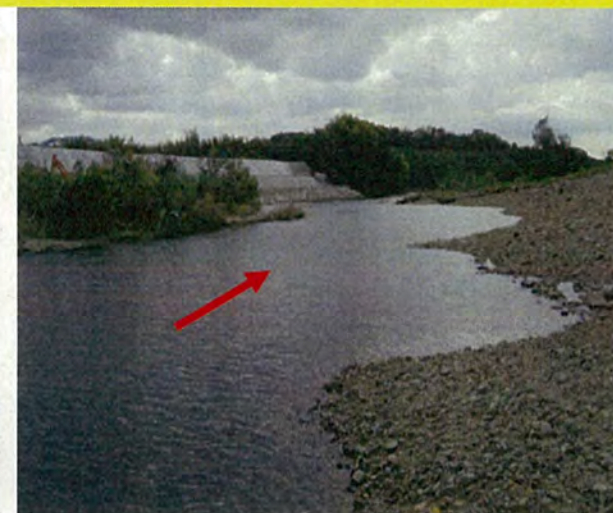
瀬替え箇所(下流部の状況)
