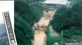
洪水調整中の矢作ダム
