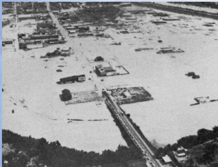
冠水した豊田市街地南部地区(昭和47年・豊田市) 7月14日矢作川流域の豪雨による冠水被害
