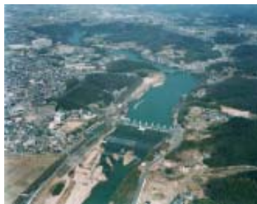
明治用水頭首工と鶴の首狭窄部
