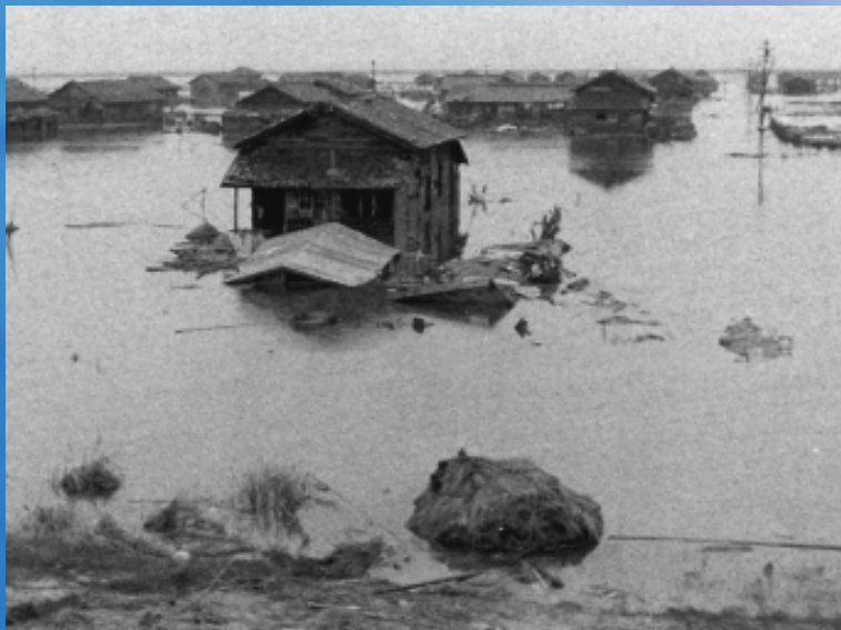
伊勢湾台風の被害 (昭和34年・碧南市) 伊勢湾台風により碧南干拓堤防の決壊。泥海と化した干拓地。
