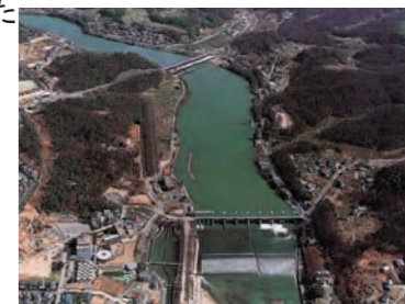
明治用水頭首工
