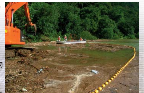
ダム貯水池の流木処理
