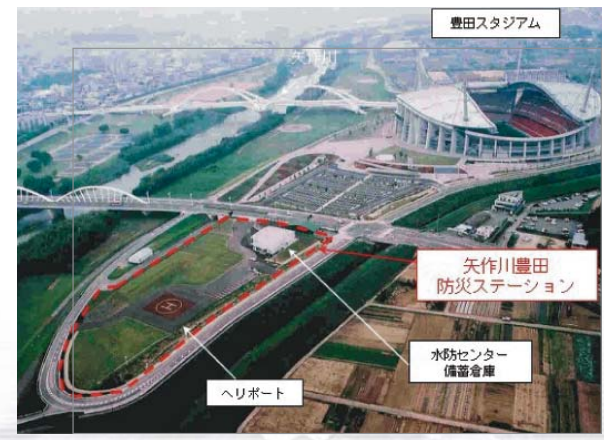
河川防災ステーション
