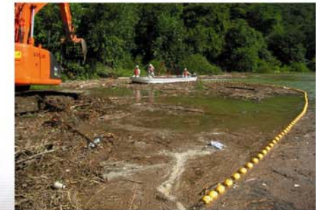
ダム貯水池の流木処理
