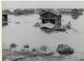
S34洪水/碧南市の被災状況
