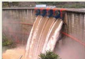
H12洪水/矢作ダム出水状況
