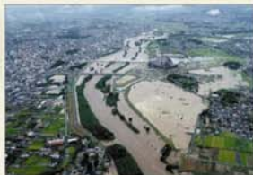
H12洪水/豊田市の越水状況
