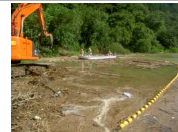
矢作ダムの流木処理
