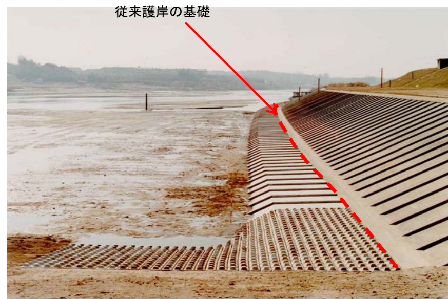
【低水護岸整備による堤防強化】
