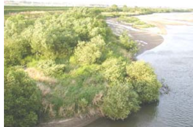
河道内樹木繁茂状況
