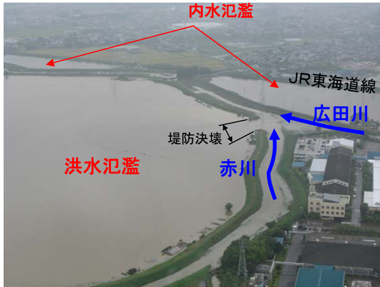
広田川堤防決壊状況
