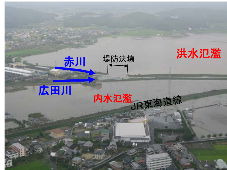
広田川堤防決壊状況
