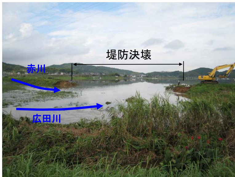
広田川右岸堤防より左岸堤防を望む
