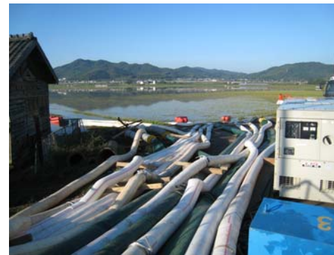
広田川の堤防決壊現場での排水作業（愛知県幸田町）
