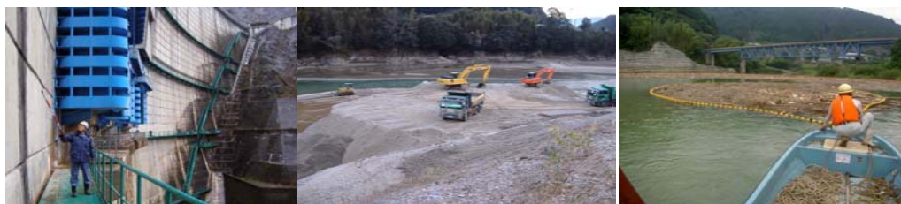
放流施設の点検状況
