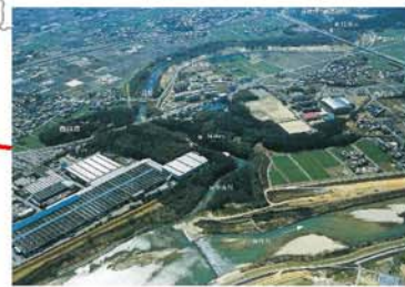
矢作古川分派地点 (河口より約 13km)
