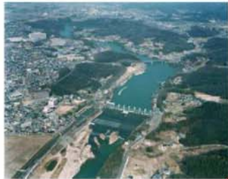
明治用水頭首工と鶴の首狭窄部 (河口より約 35km)
