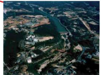
越戸ダム周辺 (河口より約 45km)
