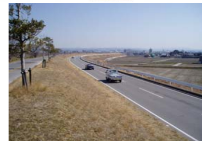
堤防リフレッシュ事業 (左岸19.0k付近)
