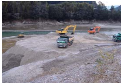
堆積土砂の掘削
