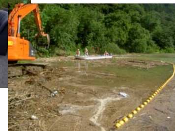
矢作ダムの流木処理
