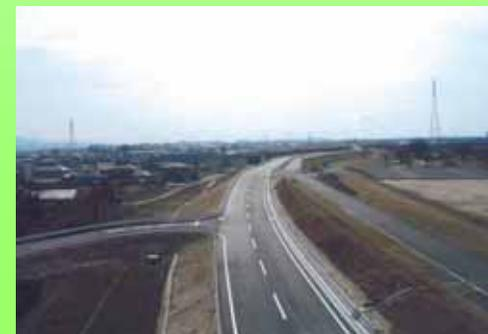
治水対策として堤防強化を図ると共に、兼用道路として有効利用する堤防リフレッシュ事業
