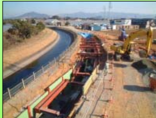
利水者による導水施設の パイプライン化
