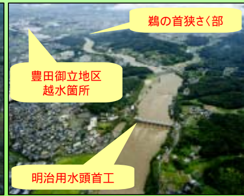
明治用水頭首工付近の出水状況(豊田市)
