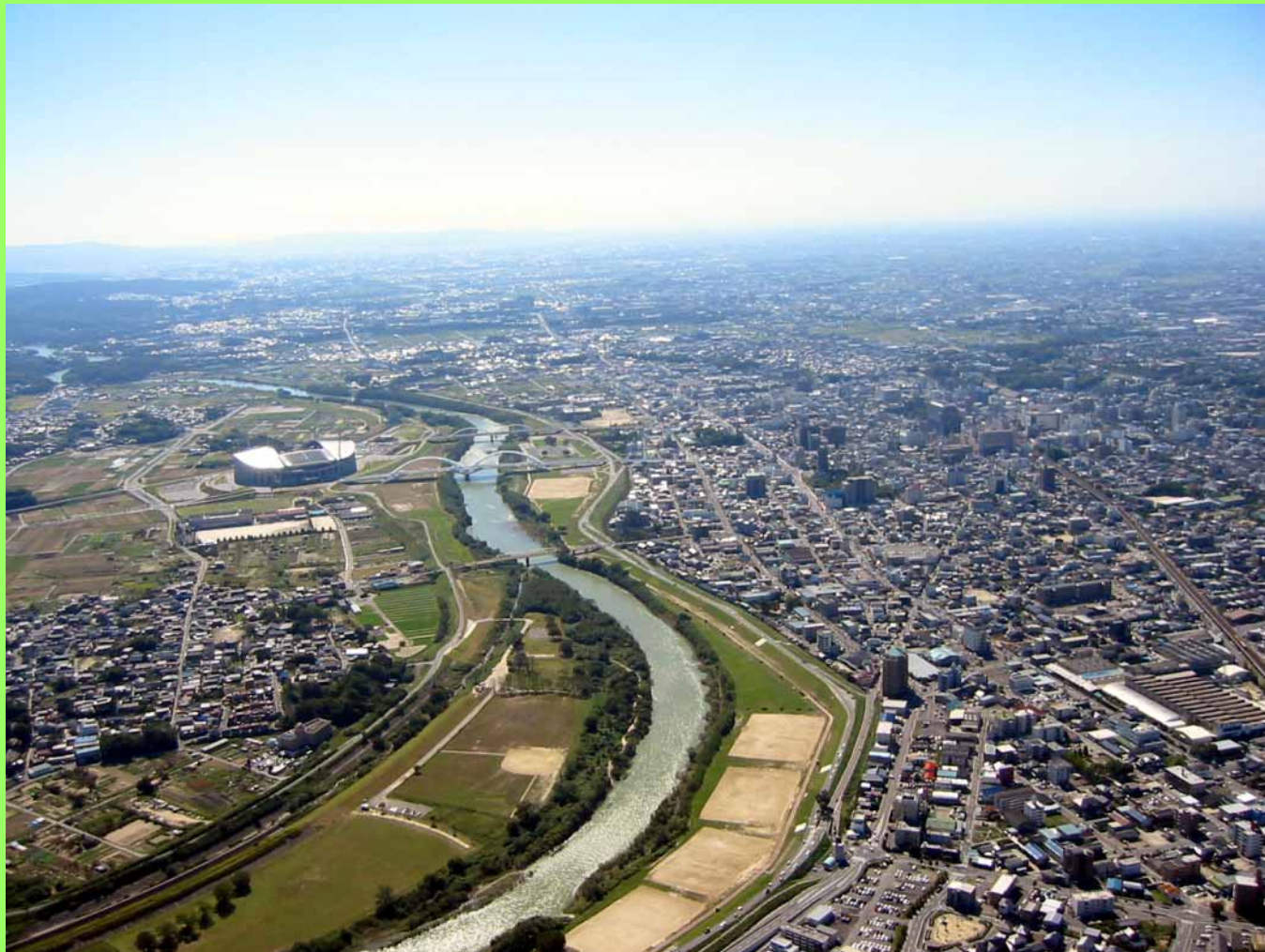
高水敷上での植生の分断例
