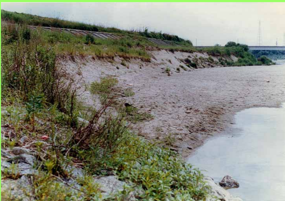
矢作川橋上流左岸側
