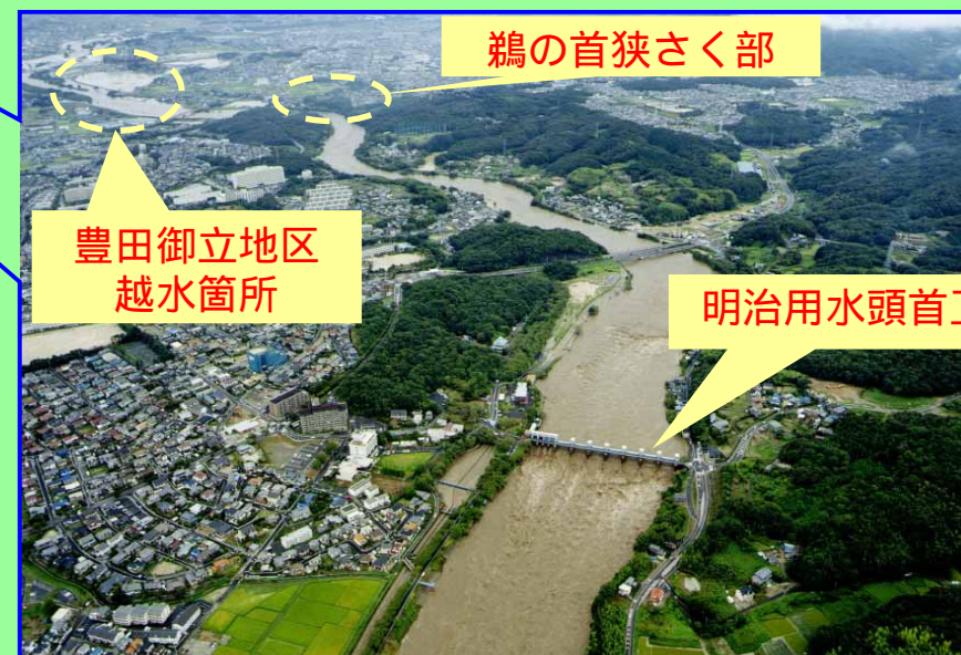
明治用水頭首工付近の出水状況 （豊田市）
