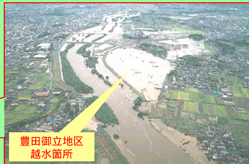
越水した矢作川（豊田市）
