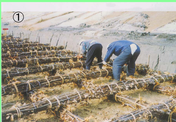
① 粗朶 そだ をマス状に編み上げる。
