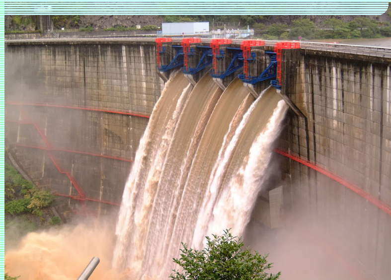
洪水調節中の矢作ダム
