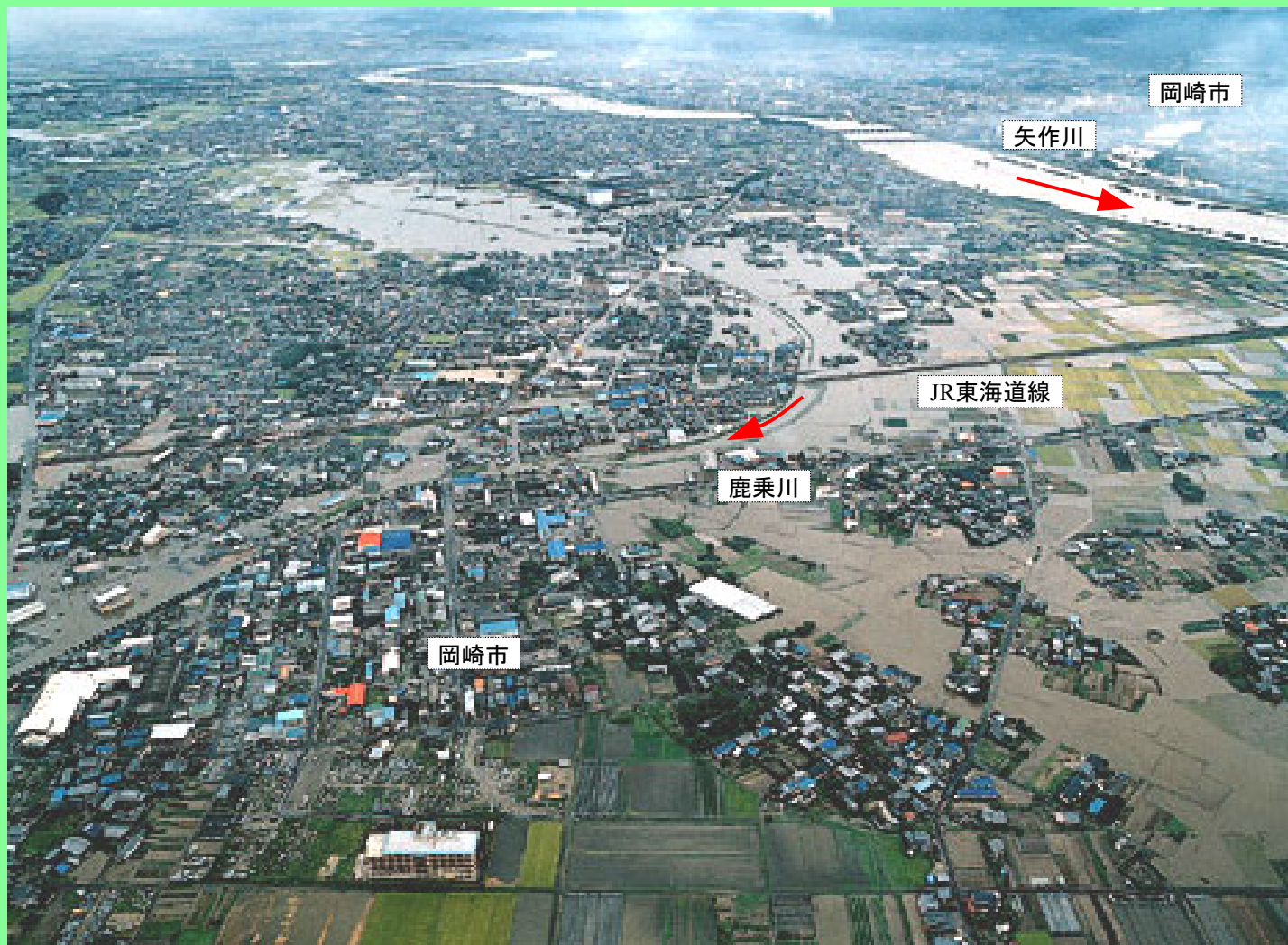
岡崎市付近の鹿乗川の浸水状況
