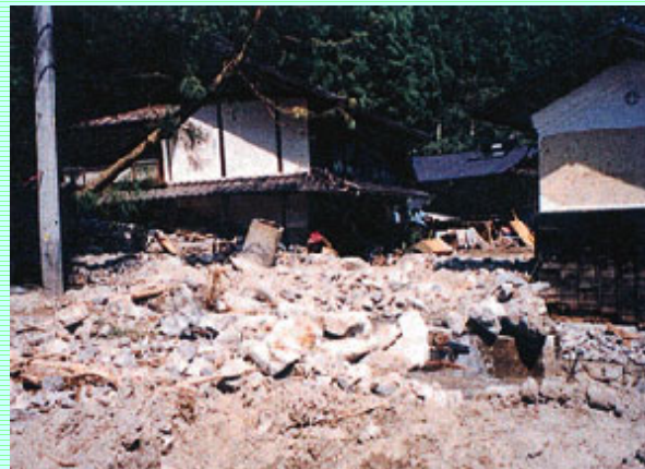
土石流により家屋埋没 (犬間沢 いぬまざわ ・上矢作町達原)
