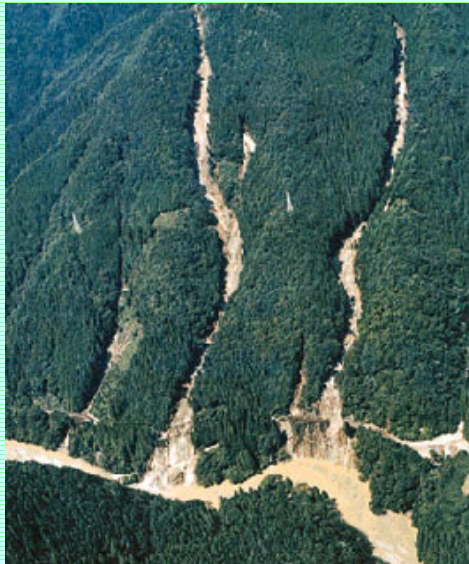
豪雨による深いつめ跡 (国道418号・上矢作町達原)
