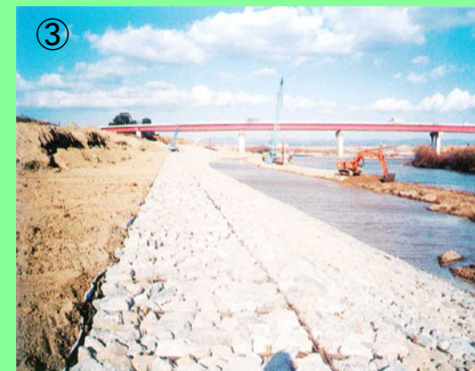
③ 敷き並べた雑石の間に生柳を挿し木する。
