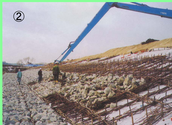
② 木杭を打ち込み、雑石を敷き並べる。
