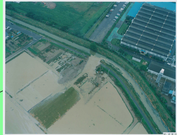
矢作古川に流入する広田川の破堤状況(幸田町)
