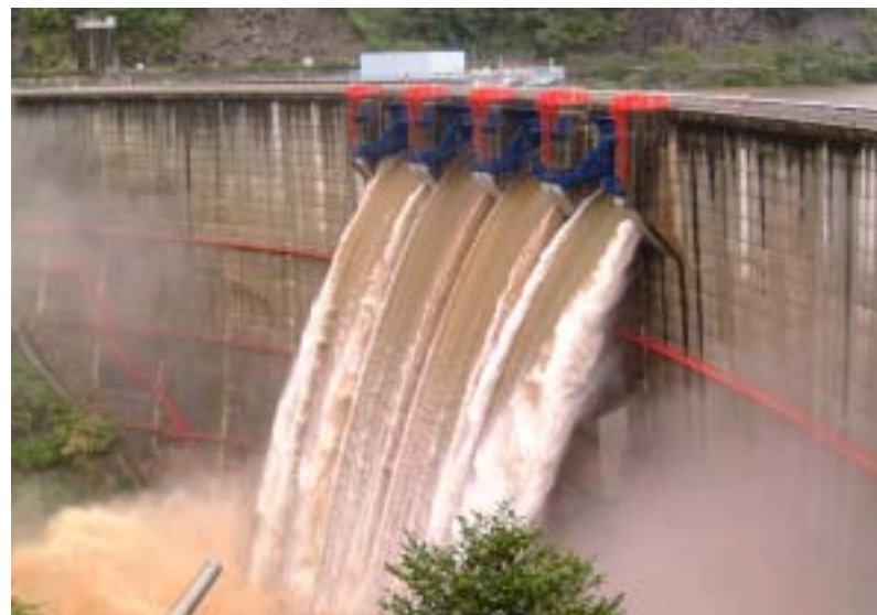
洪水調節中の矢作ダム
