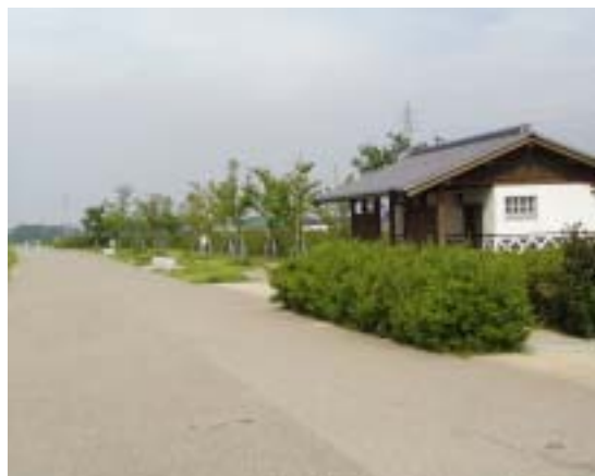
愛知県西尾市 桜つつみモデル事業 堤防リフレッシュ事業施工箇所
