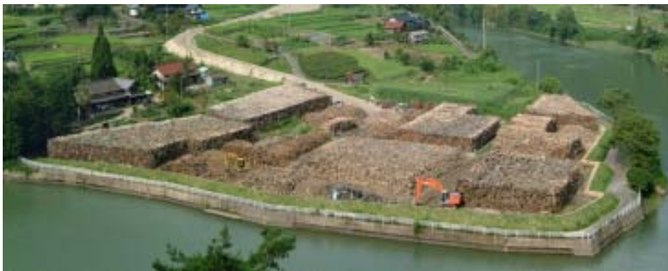
岐阜県串原村閑羅瀬 矢作ダムに貯まった流木置き場
