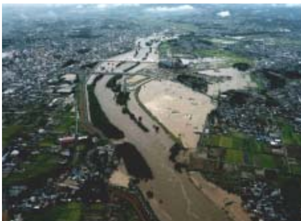
愛知県豊田市 東海豪雨による浸水状況
