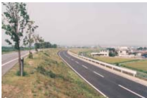
愛知県岡崎市矢作川右岸 堤防リフレッシュ事業
