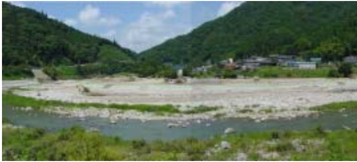
愛知県旭町島崎 河川敷広場復旧状況
