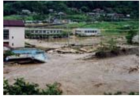
愛知県旭町小渡 幼稚園・小学校の被災状況
