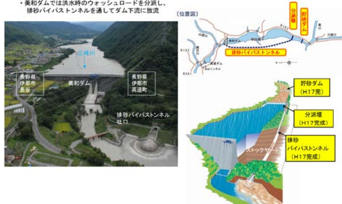
図 4-5 対策工法のイメージ：土砂バイパストネルのイメージ（美和ダム）
