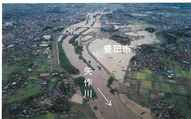
豊田市御立町(矢作川左岸)越水状況
