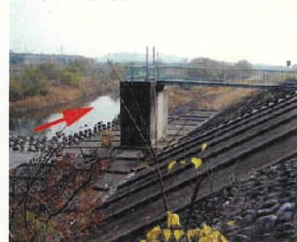
堤防の損傷なし
