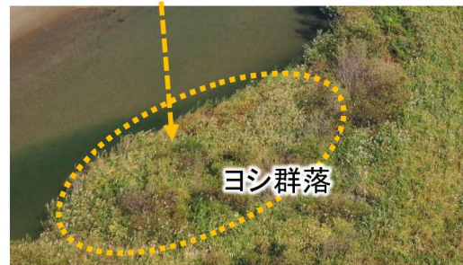
○施工後10年目 (R5.11)
