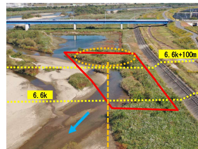
■H29年度施工区 (6.6k左岸付近)
