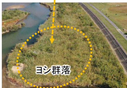
○施工後13年目 (R5.11)
