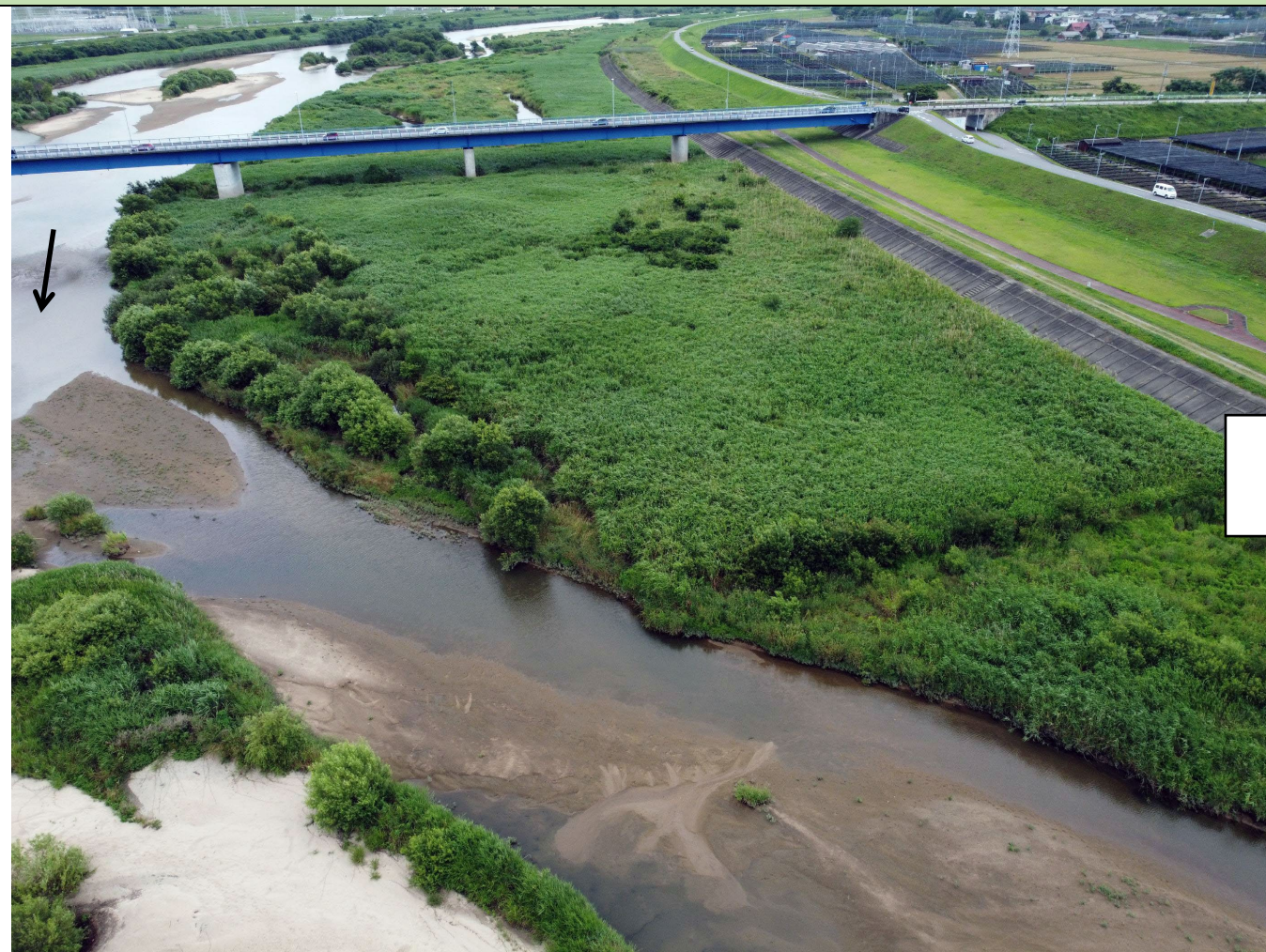
施工前（R4.6撮影）
