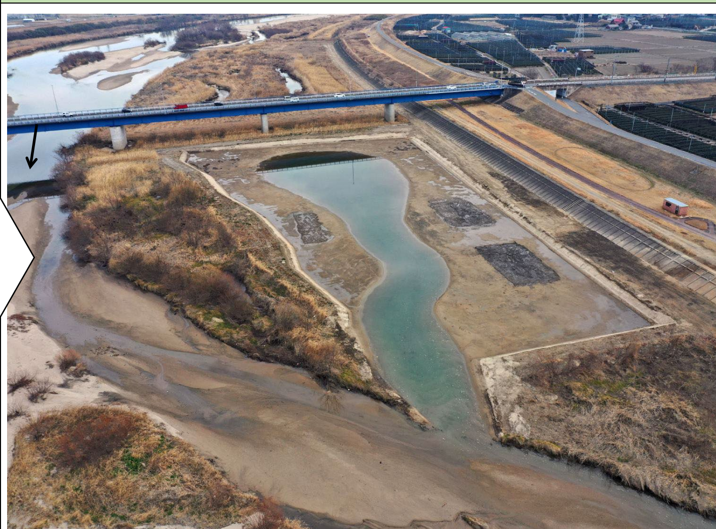
施工直後（R5.2撮影）
