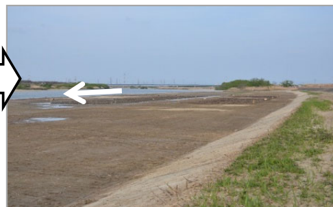
○施工直後 (H23. 4)
