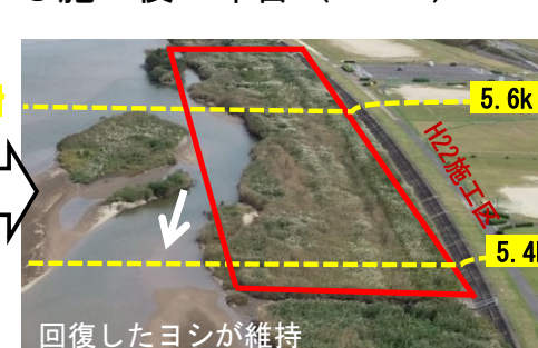
○施工後11年目 (R3. 10)
