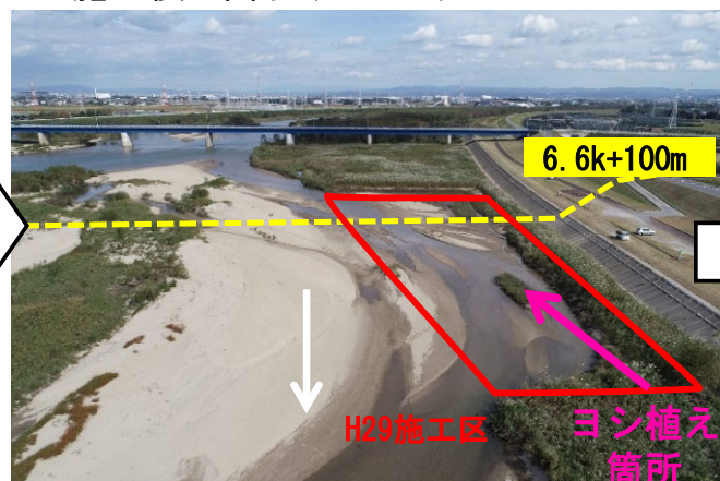
○施工後1年目（H30.10）
