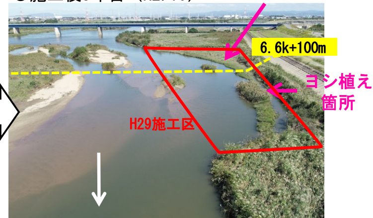
○施工後3年目（R2.10）
