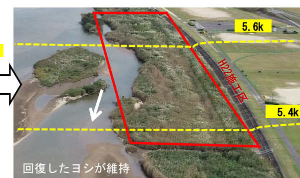
○施工後11年目 (R3. 10)
