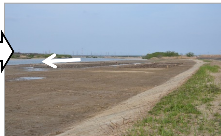
○施工直後 (H23. 4)
