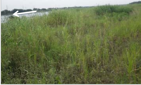
○施工後2年目 (H24.9)
