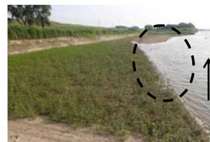
水際部で洗掘傾向
