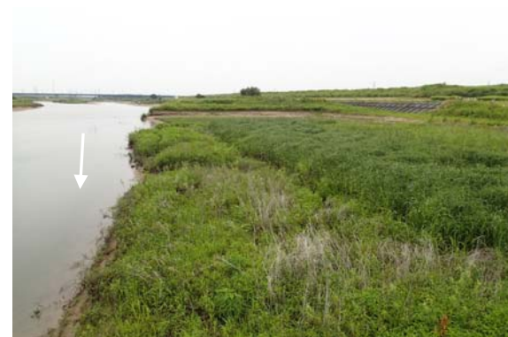
■H25 年度施工区 (6.0km 下流付近より上流側を望む) (春季)
