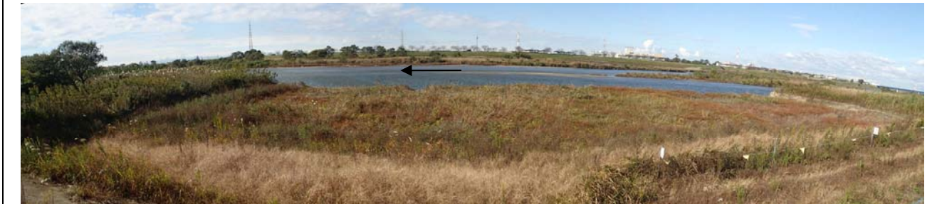
施工後 2 年目 [H27. 11. 10]
