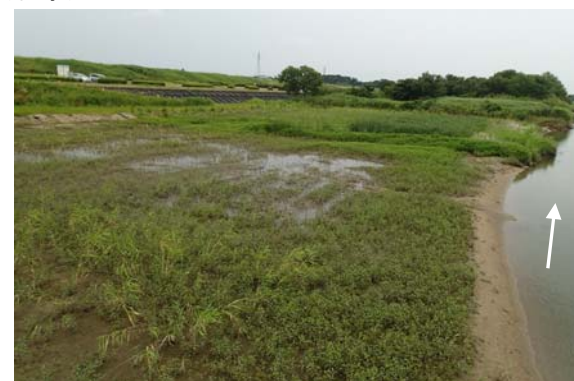
■H26 年度施工区 (6.0km 上流付近より下流側を望む) (春季)
