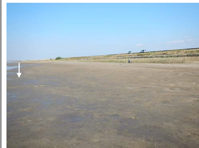
■ 0.6k+00m 側線付近より上流側を望む
