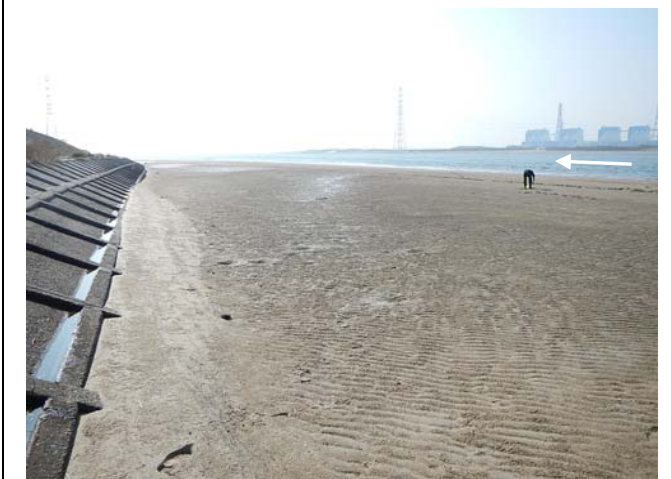
■ 0.2k+00m 側線より下流側を望む
