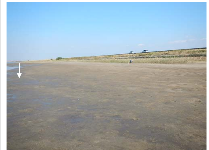
■ 0.6k+00m 側線付近より上流側を望む
