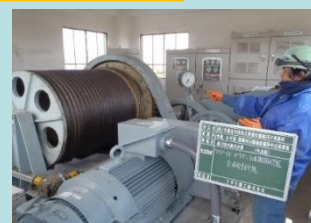
(機械設備の点検)
