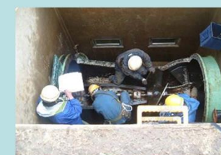
(ポンプ設備の点検・整備)
