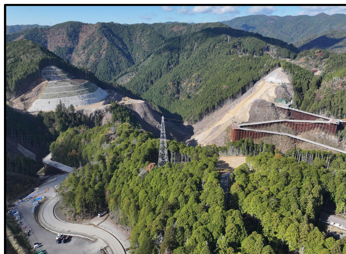
② 上流側より
