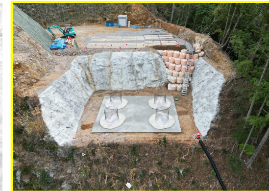
257号小松地区道路建設(A1橋台)
