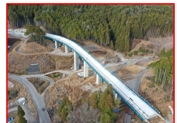
257号2号橋床版工
