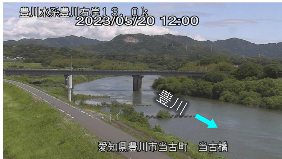
当古水位観測所13.0k付近 平常時の状況
