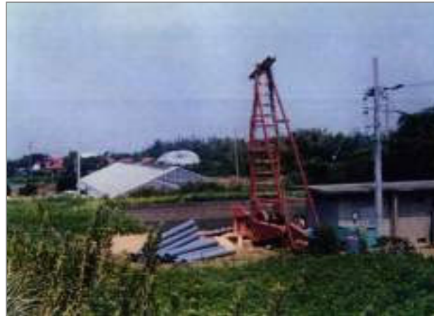
応急井戸掘りの様子 (平成6年)
