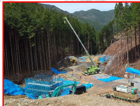
設楽根羽線3号橋（橋脚部）
