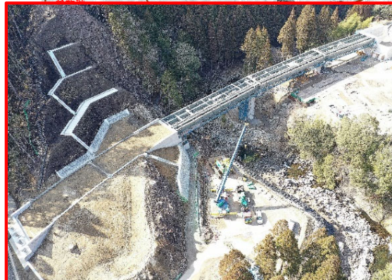
瀬戸設楽線1号橋上部工
