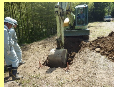
重機による試掘
