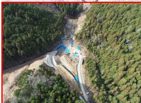
設楽根羽線3号橋下部工
