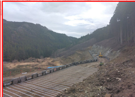
大名倉地区道路建設
