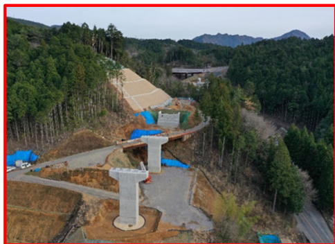
国道257号2号橋左岸下部工
