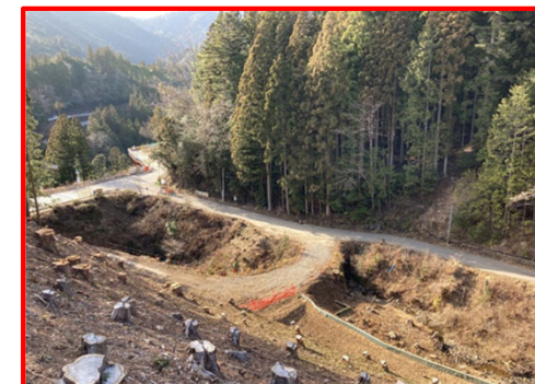
国道257号3号橋下部工
