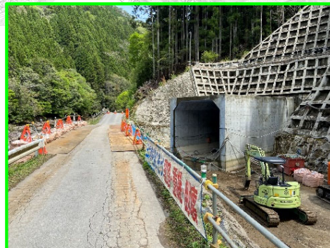
堤外仮排水路（吐口部）
