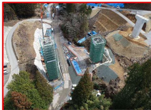
国道257号添沢地区橋梁下部工
