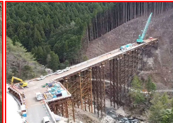
松戸地区工事用進入路
