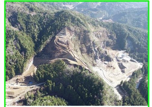
原石山CSG材量採取
