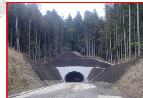
設楽根羽線1号トンネル坑口部完成
