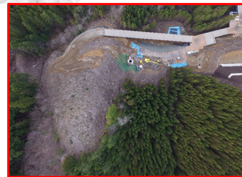
設楽根羽線4号橋下部工
