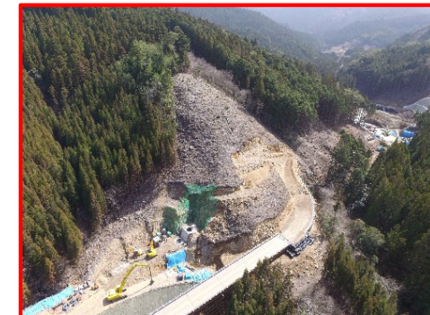
設楽根羽線4号橋（土工部）
