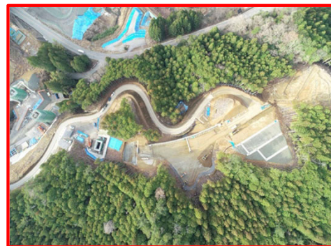
国道257号2号橋右岸下部工
