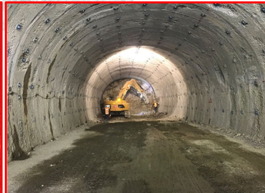
トンネル（1号・2号）
