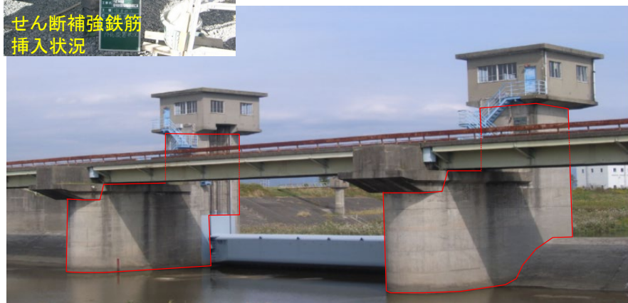
豊川放水路分流堰耐震補強(H24年度完成)
