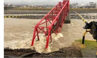
上田電鉄別所線(千曲川橋梁)
