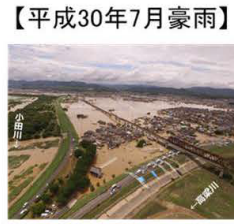
⑥小田川における浸水被害 (岡山県倉敷市)
