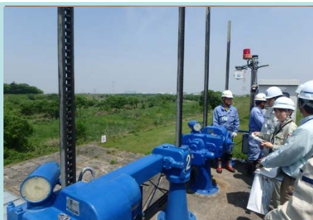
(機械設備の点検)
