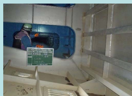
(ゲート設備の点検・整備)
