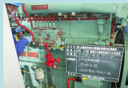
(エンジンの点検・整備)
