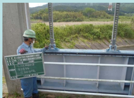
(樋管ゲートの点検)
