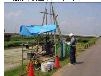
堤防の調査(ボーリング)
