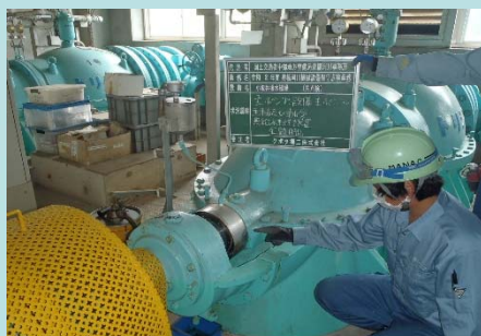
(ポンプ設備の点検・整備)
