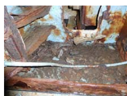
ローラ類の支持架台が朽ち果てている
