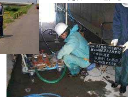
樋管の連通試験
