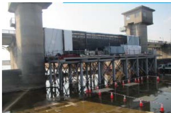
ローラ類の支持架台が朽ち果てている
