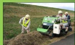
堤防点検のため除草で発生する刈草
