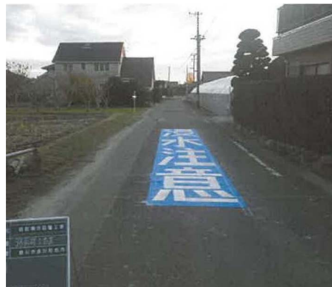
金沢地区の道路の注意喚起表示事例
