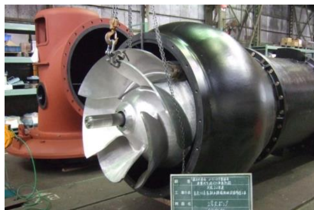
古川排水機場のポンプ分解整備 (補修、研磨、塗装) 状況
