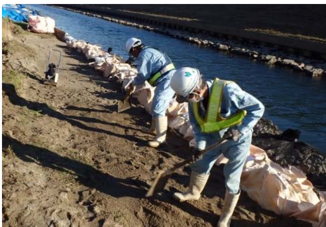
堤防の維持工事
