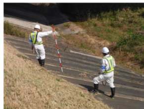
堤防・護岸点検
