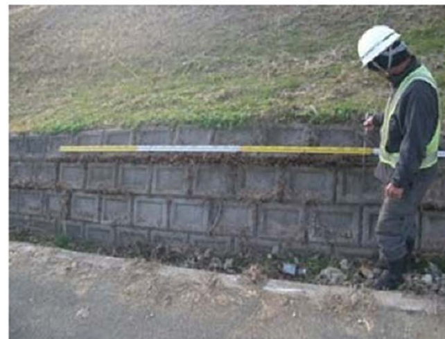
堤防点検の状況
