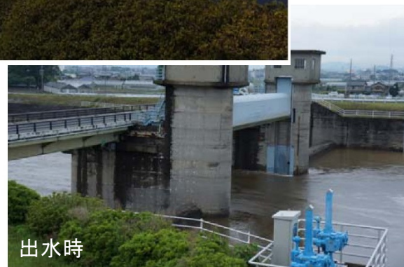
豊川放水路 分流堰
