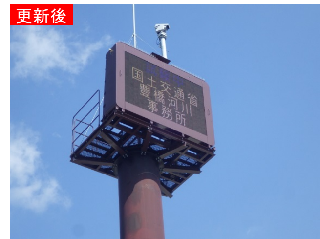
放流警報表示盤の更新状況
