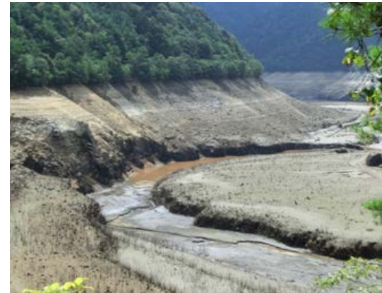
枯渇する宇連ダム (平成25年9月)
