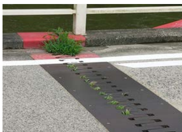
(従来形式) 鋼製フィンガージョイント
