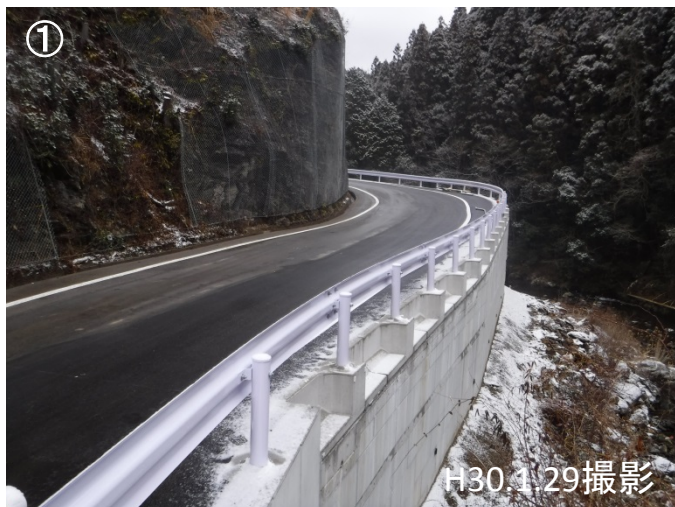
① 工事用道路(小松田口線拡幅) 【平成30年1月完成】
