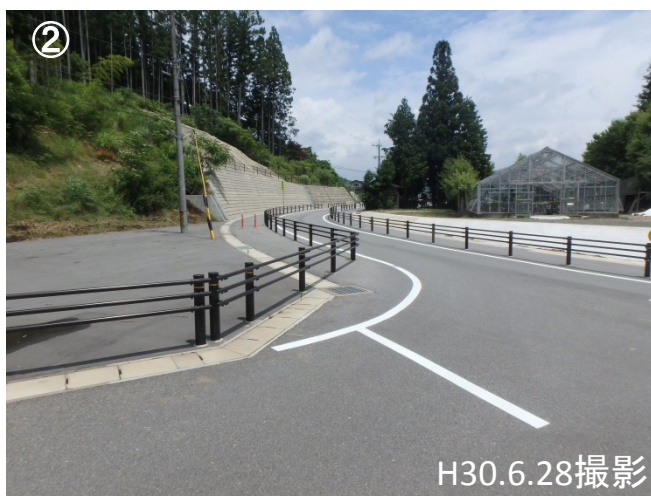
② 町道町浦シウキ線 【平成28年6月完成】
