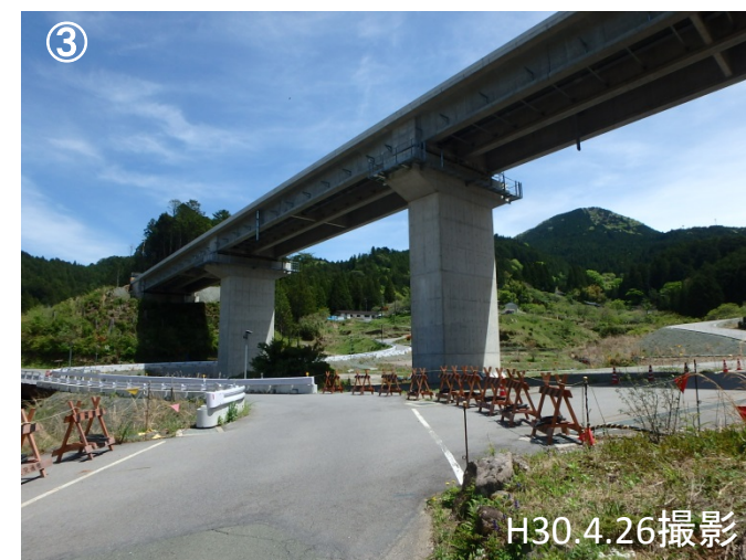
③ 付替県道設楽根羽線(2号橋(仮称)) 【平成28年10月完成】
