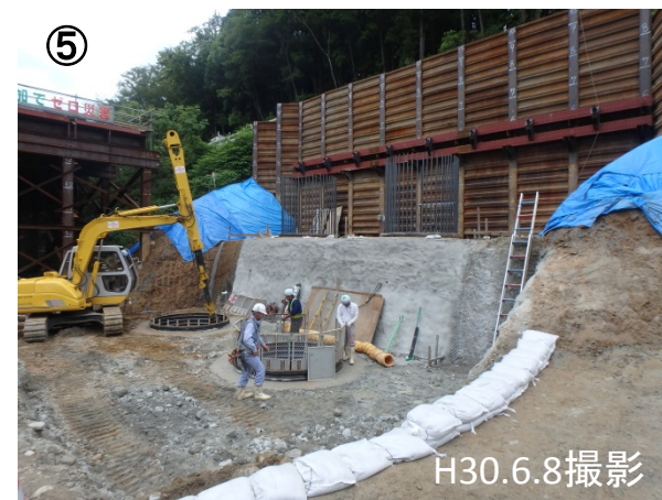
⑤ 付替県道設楽根羽線(1号橋(仮称)) 【下部工深礎杭】
