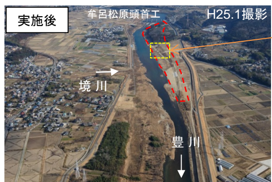
河道掘削状況 (H26年度完成)
