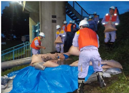
岐阜市水防団 漏水対策
