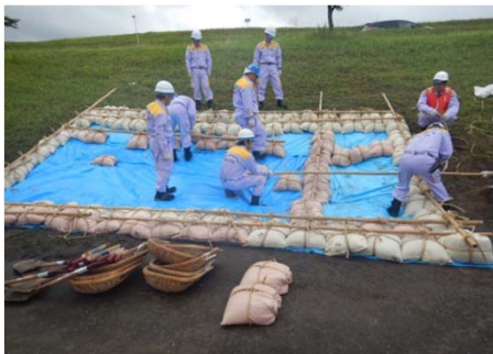
岐阜市水防団 堤防法崩れ対策
