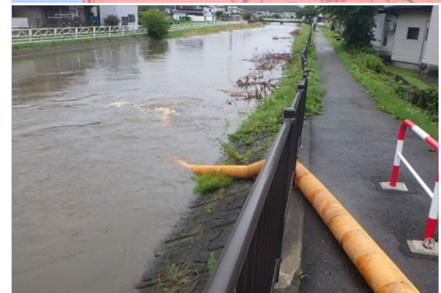
実証実験参加自治体: 秋田県秋田市 (令和6年7月9日 浸水状況)
