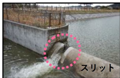
▲スリットの設置状況
