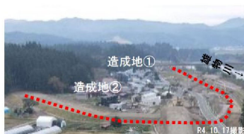
移転家屋の建設が進む状況
