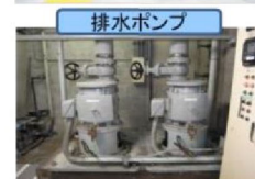
地下への浸水防止対策
