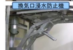
地下への浸水防止対策
