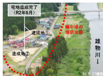
移転先宅地造成完了状況
