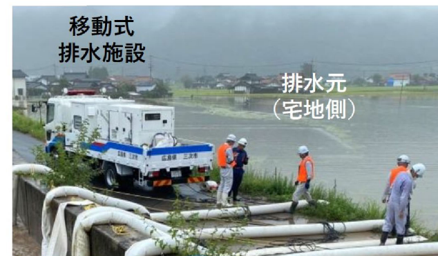
樋管のゲートにポンプを設置
