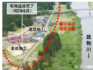
移転先宅地造成完了状況
