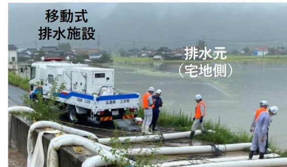
樋管のゲートにポンプを設置
