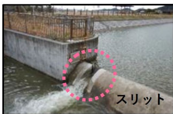
▲スリットの設置状況
