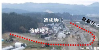
移転家屋の建設が進む状況
