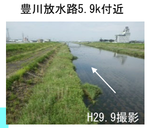
(ヨシ原創出後の豊川放水路)
