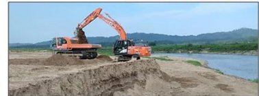
河道掘削・積込(場内運搬)の状況 (R4.8.23 撮影)
