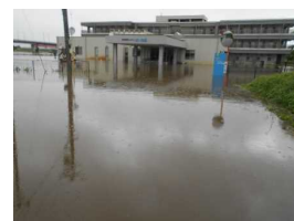
浸水時の状況 (喜多方市提供)
