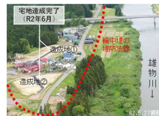
移転先宅地造成完了状況
