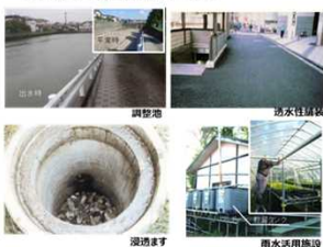
雨水貯留浸透施設の例
