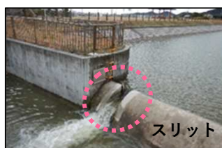
▲スリットの設置状況
