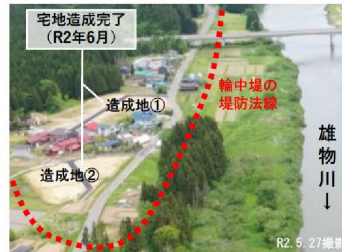
移転先宅地造成完了状況
