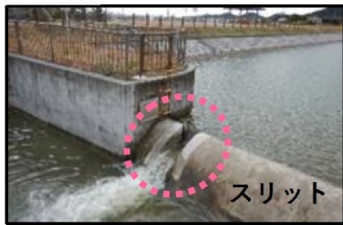
▲スリットの設置状況
