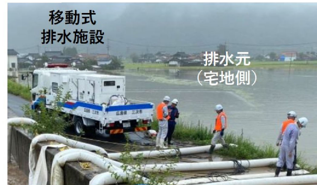
樋管のゲートにポンプを設置
