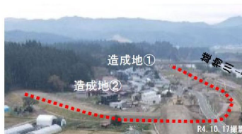
移転家屋の建設が進む状況
