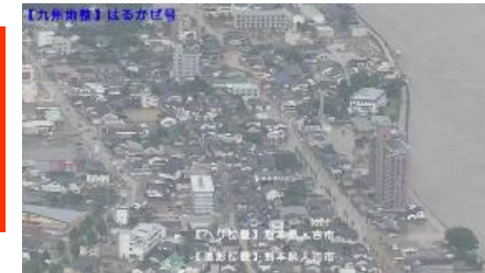
⑪球磨川における浸水被害状況 (熊本県人吉市)
